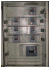
固定分隔式安装方式 Fix type installation
