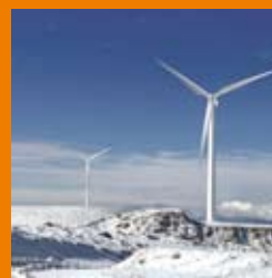
魏德米勒监控系统
